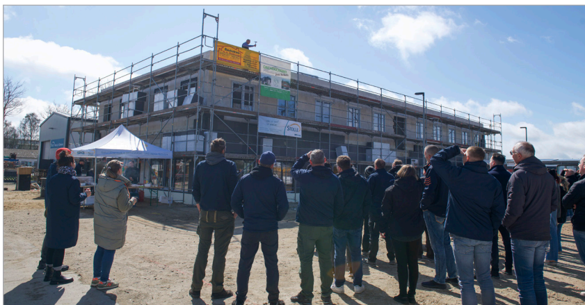
Ein besonderer Moment auf der Baustelle: der Richtspruch
